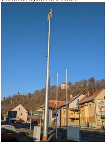
Im Bereich der Saalstraße wurde im November 2022 eine elektronische Sirene installiert. Die elektronische Sirene ist neben einem definierten Schallpegel mit einer Akkupufferung ausgestattet, denn bei einem Stromausfall muss sie noch mindestens vier Warn- und Entwarnzyklen durchlaufen können.
