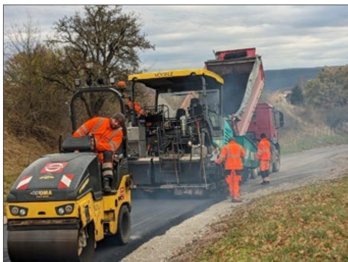
Einbau der Deckschicht
