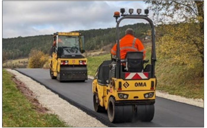
Die Deckschicht wird gewalzt
